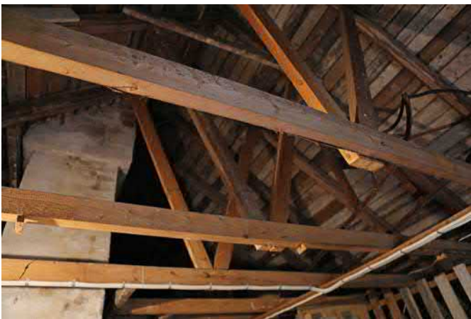
Ullakon kattorakenteita rakentamattomalta puolelta.
