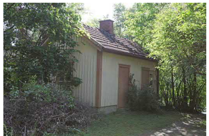
Säilytettäväksi ehdotettu entinen saunarakennus nykyinen varasto.
