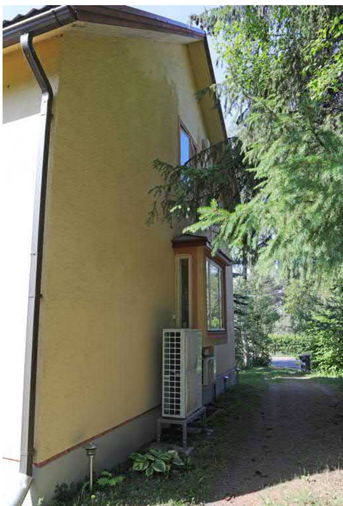
Julkisivu päädyistä. (pohjoisesta)
