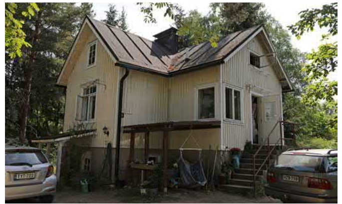
Julkisivu edestä (lännestä).
