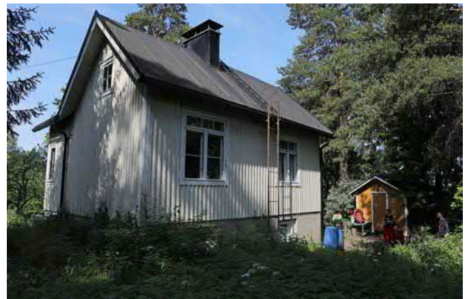
Julkisivu takaa (idästä).
