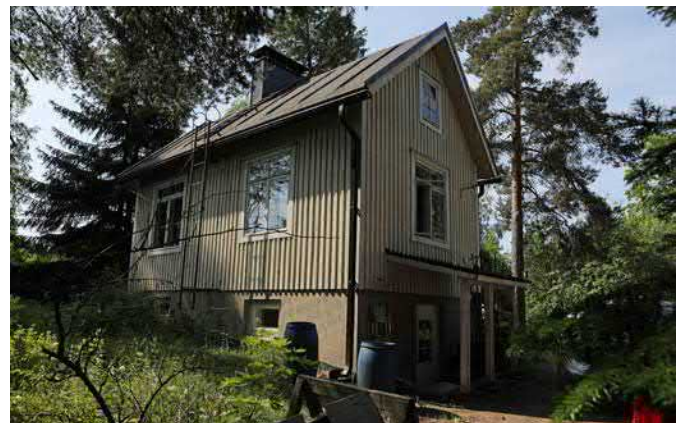
Julkisivu päädyistä (pohjoisesta).
